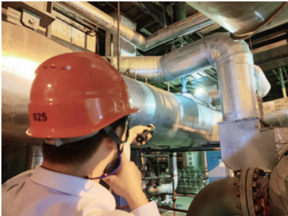
巡检值班员现场检查。
