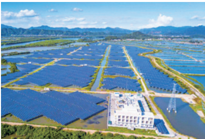
江门汶村一期光伏电站
