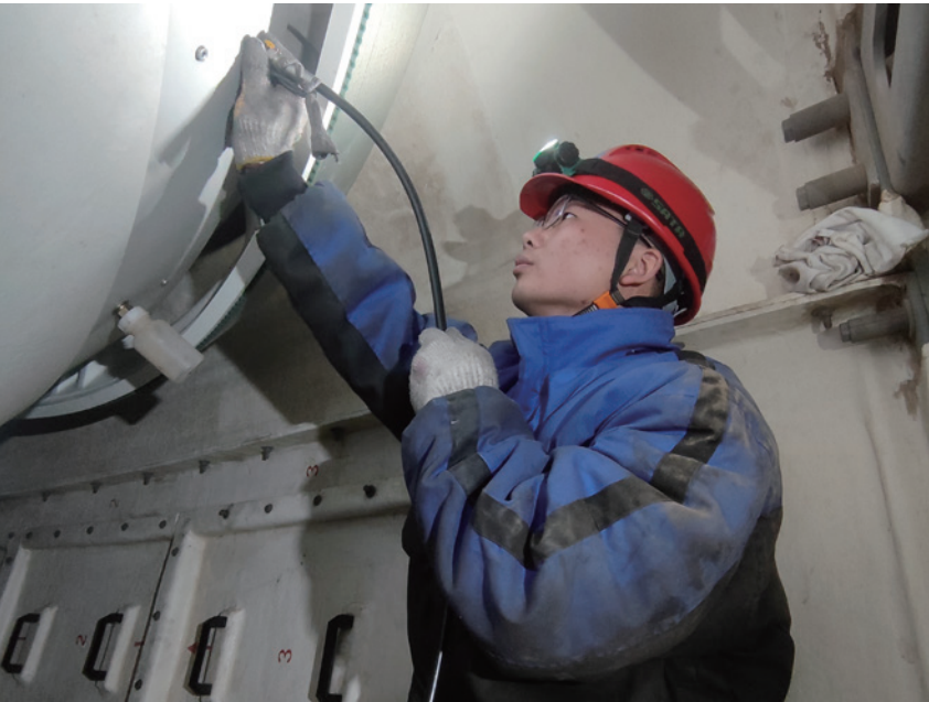
临西万辉风电场运维骨干独立开展检修工作。
